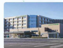
小千谷総合病院 (小千谷市)
