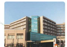
長岡中央総合病院 (長岡市)
